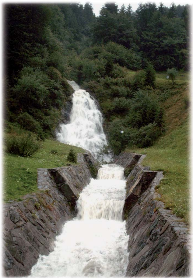
Il torrente "Ventolosa" in piena
